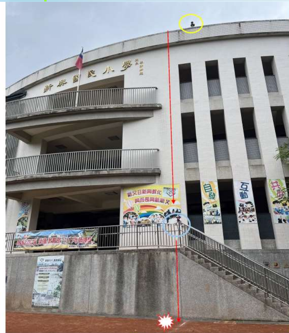
林○○行走女兒牆上方並跨越雨量觀測器時失足墜落(高度約16公尺), 雙腳先撞到1樓樓梯扶手後, 再掉落至地面。
