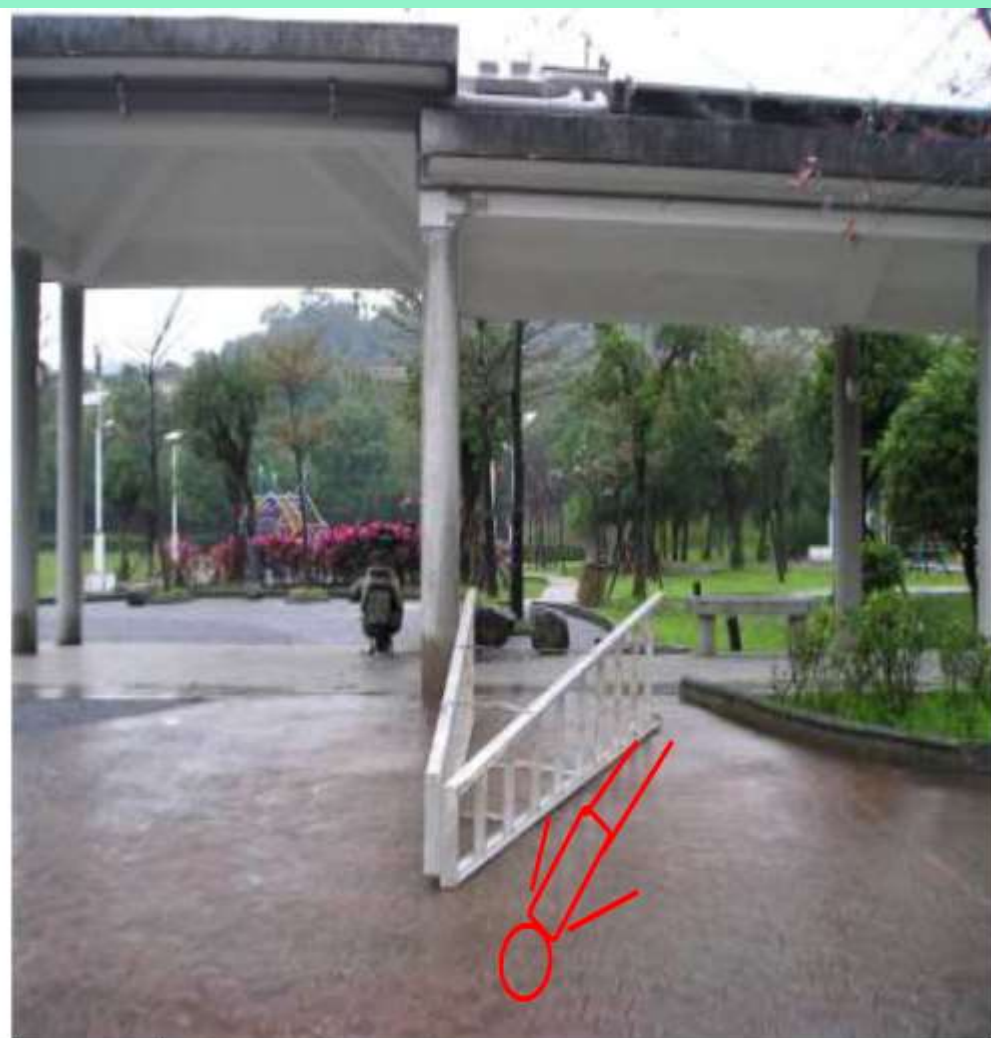
說明三 災害發生時合梯往道路方向倒下，罹災者自合梯上墜落於人行道地面。
