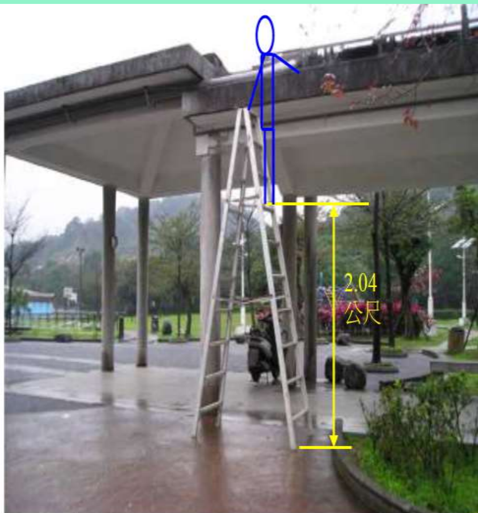
說明二 罹災者站在合梯右側由下往上數第 7 階踏板處，用手檢拾迴廊屋頂邊緣水溝內垃圾，該踏板距地面 2.04 公尺。
